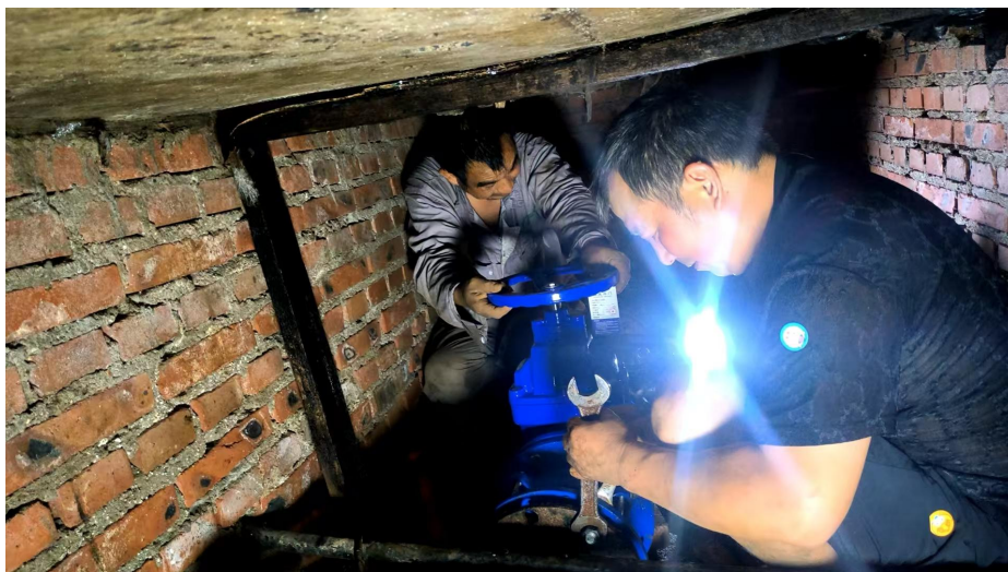
图 6-4 学校连夜完成供水主管道抢修
