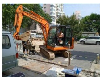
按照公安部门要求校门口安装防撞设施
