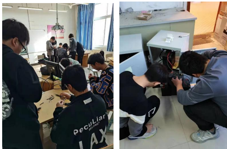
图 66-67 学院教师带领学生进行校内实践项目创新-23 号楼号中心机房进行综合布线
