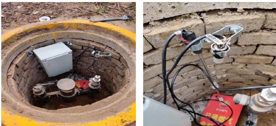
图 69：燃气阀井智能监测技术应用于燃气集团
