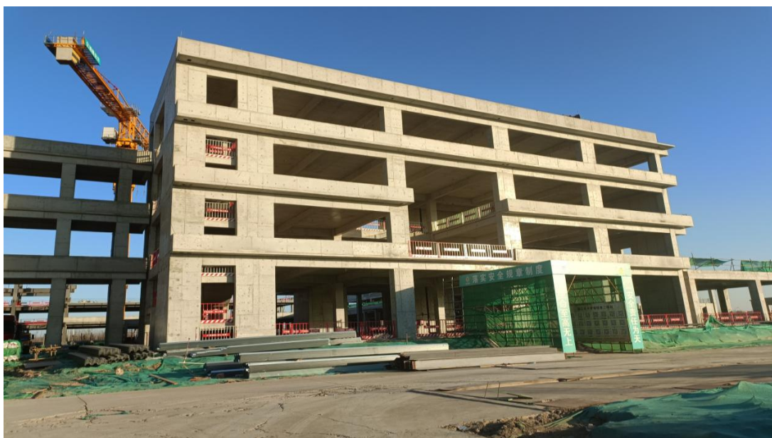
图 5-11 二号楼主体结构完工图
