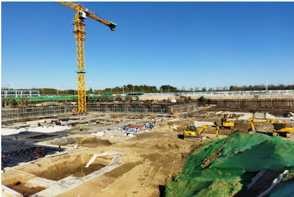
图 3-1 新院区建设现场
