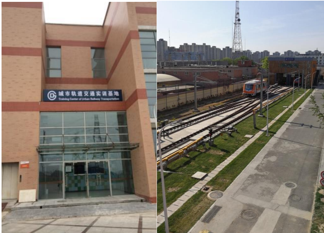
图4 城市轨道交通实训基地
